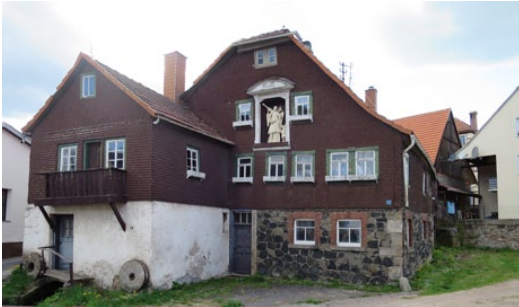
Braunsmühle vor der Sanierung
